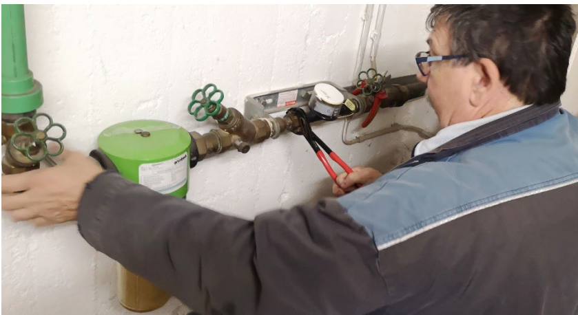
Ein Installateur mit 38-jähriger Berufserfahrung ist auch im Ruhestand eine wertvolle Arbeitskraft. Der Staat unterstützt solche Arbeitsmodelle durch Steuervergünstigung. Foto: Axel Küppers
